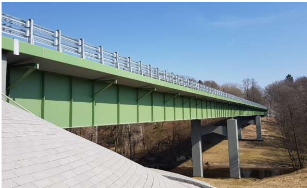
Zdjęcie 1. Konstrukcja mostu po wymalowaniu.
