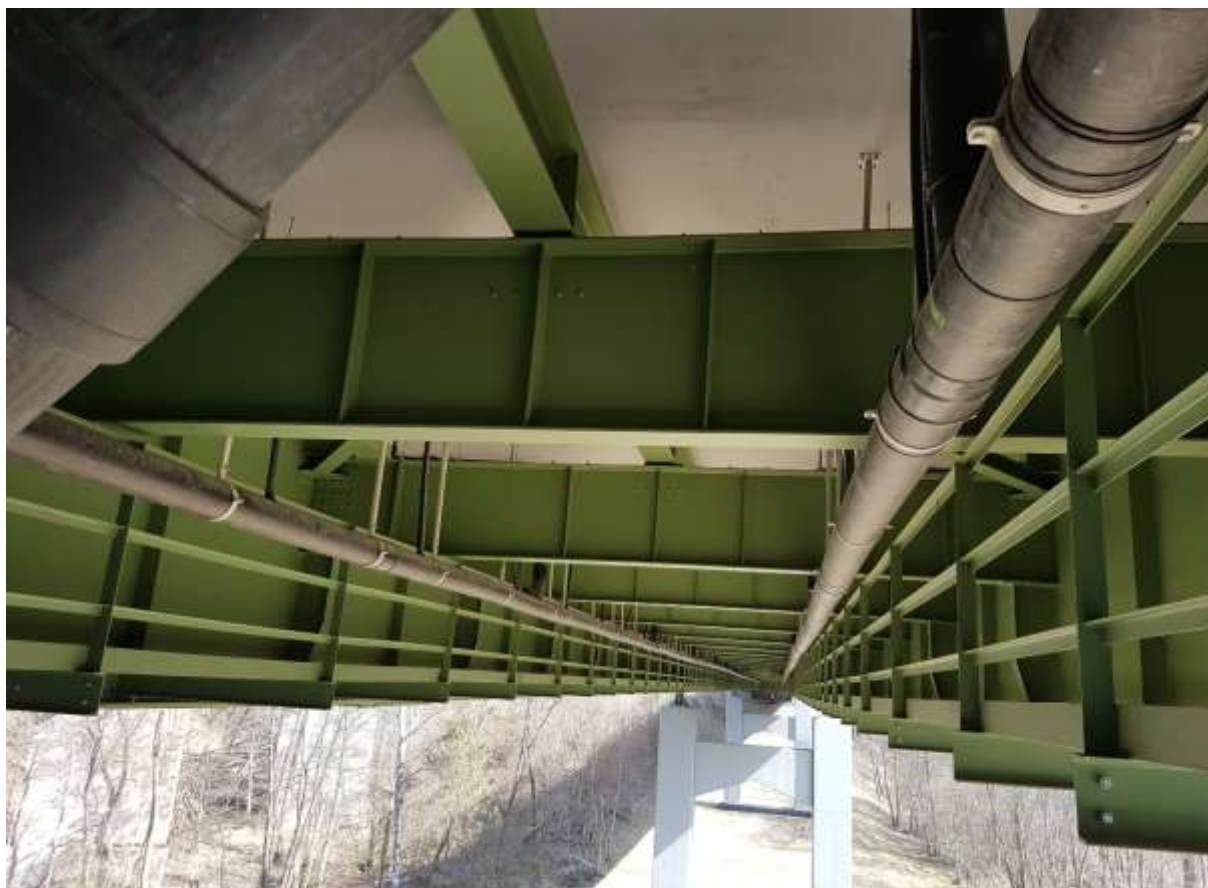
Zdjęcie 4. Konstrukcja mostu po wymalowaniu.
