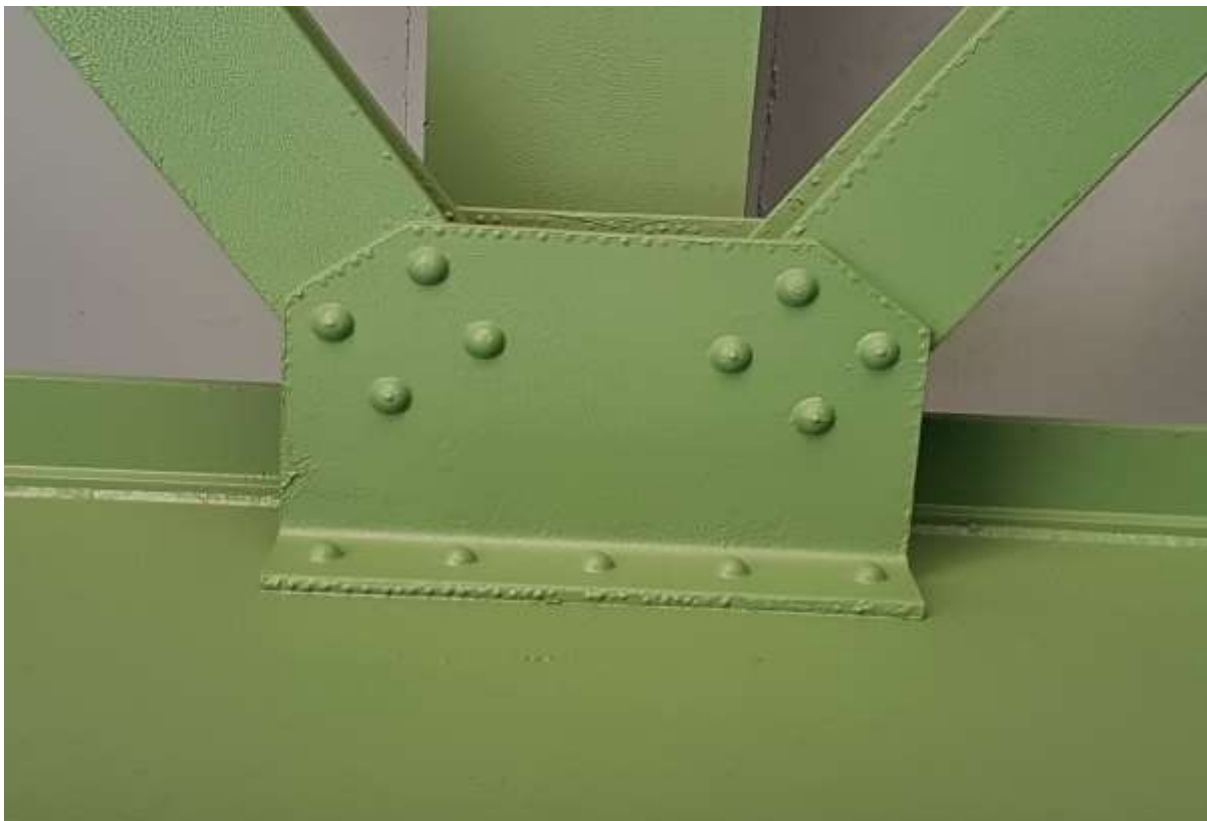
Zdjęcie 7. Konstrukcja mostu po wymalowaniu
