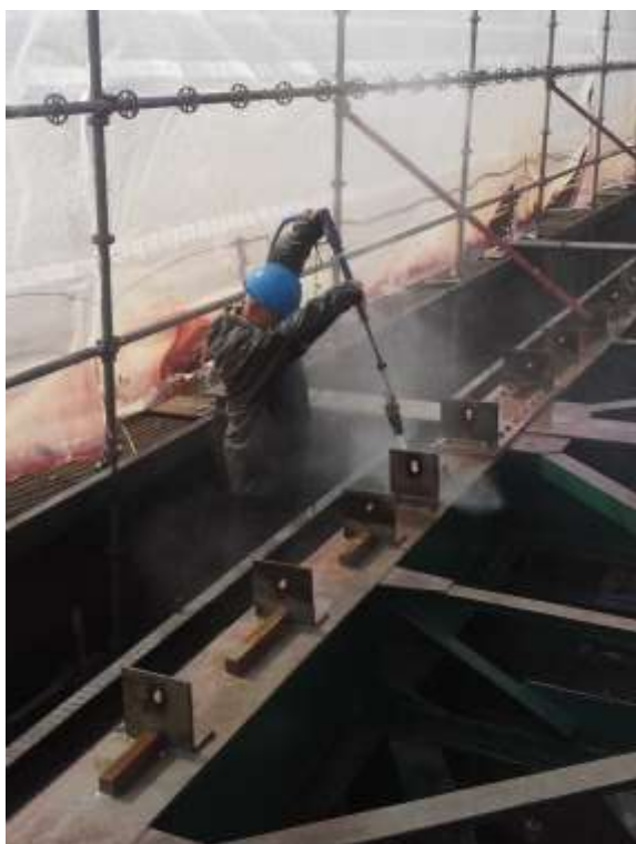
Zdjęcie. 1 konstrukcja w czasie czyszczenia wodą po wysokim ciśnieniu
