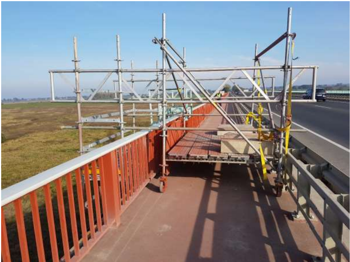
4. Konstrukcja w trakcie malowania 1 warstwy.
