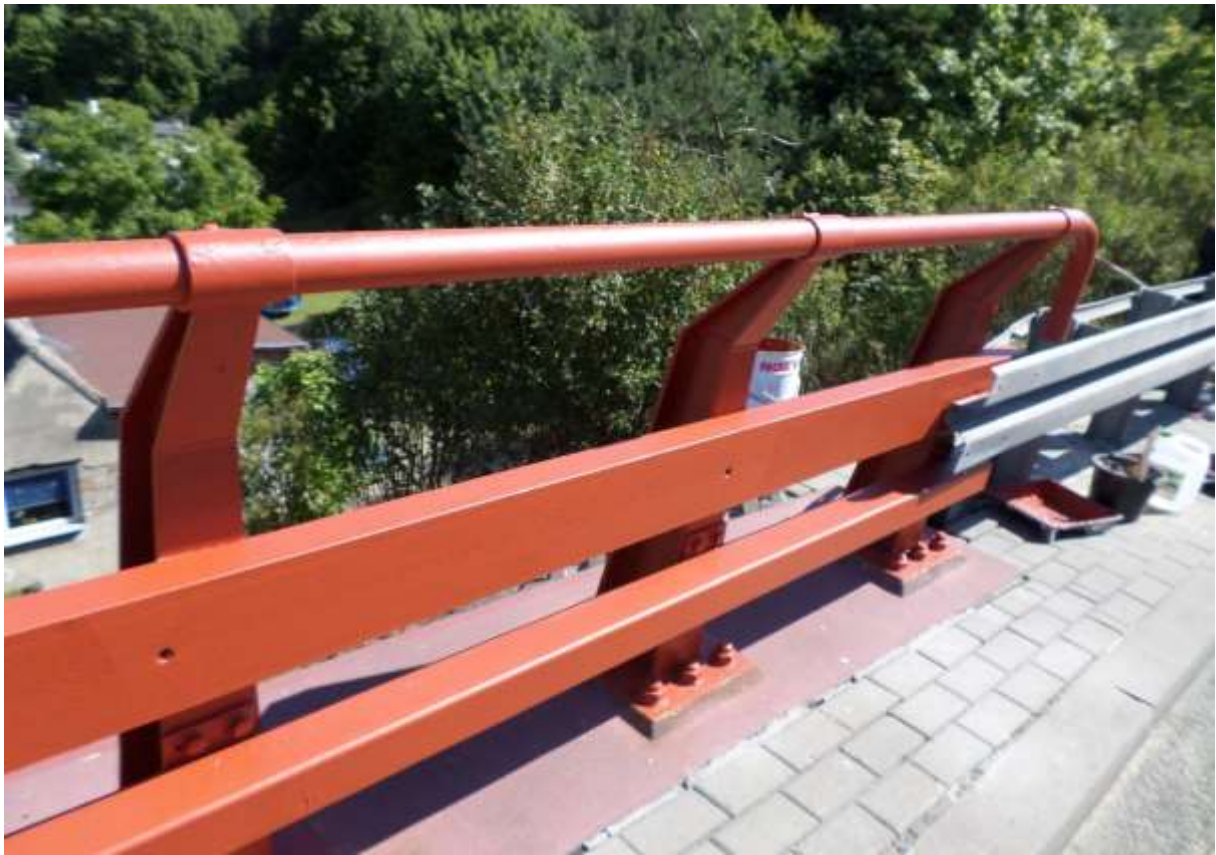
Zdjęcie 5. Nakładanie 1 warstwy Noxyde czerwony żelazowy
