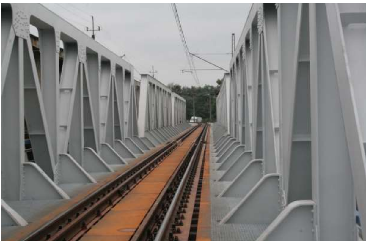
Zdjęcie 11. Konstrukcja po aplikacji farby Noxyde
