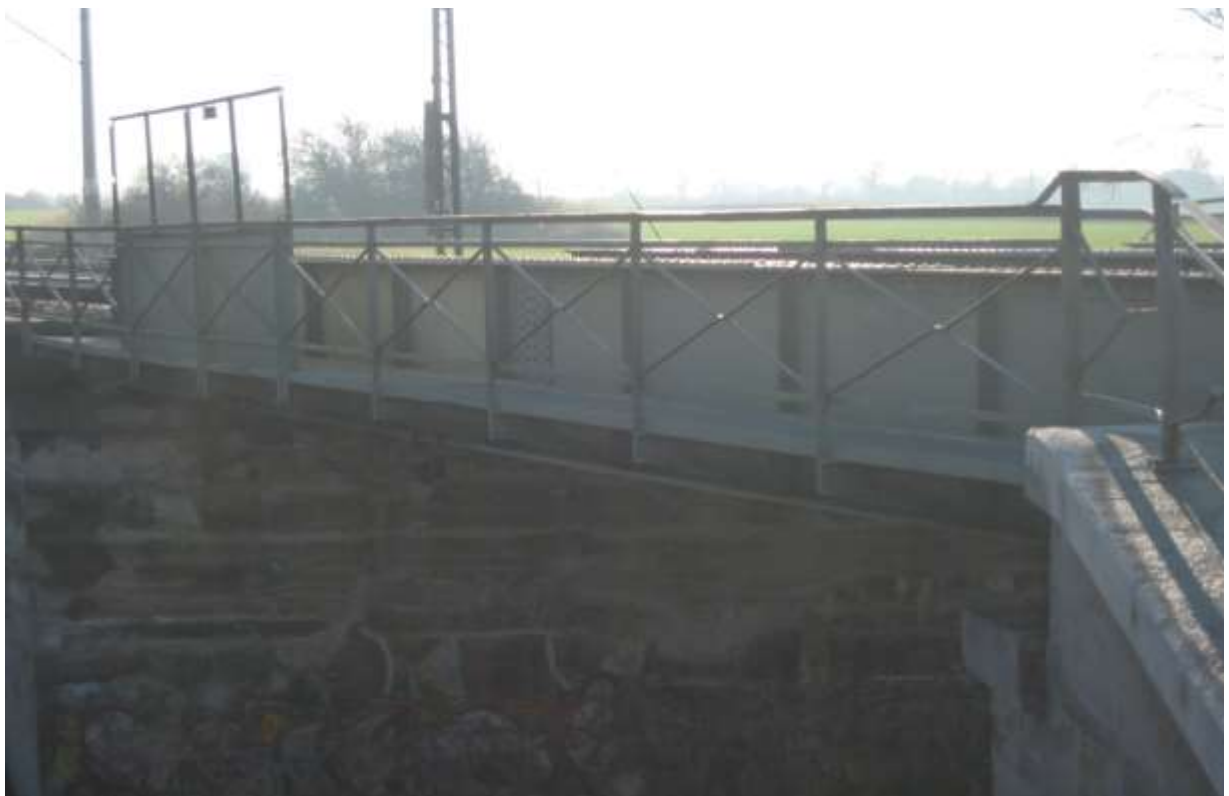
Zdjęcie 4. . Most kolejowy Opole ul. Głogowska –stan powłok 8 lat od aplikacji.
