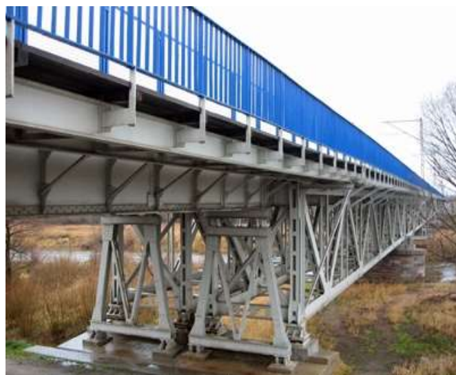
Zdjęcie 6. Stan konstrukcji 2 lata od wymalowania
