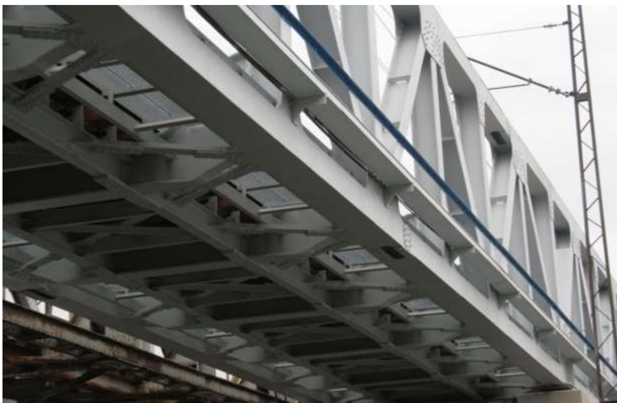
Zdjęcie 13. Konstrukcja po aplikacji farby Noxyde
