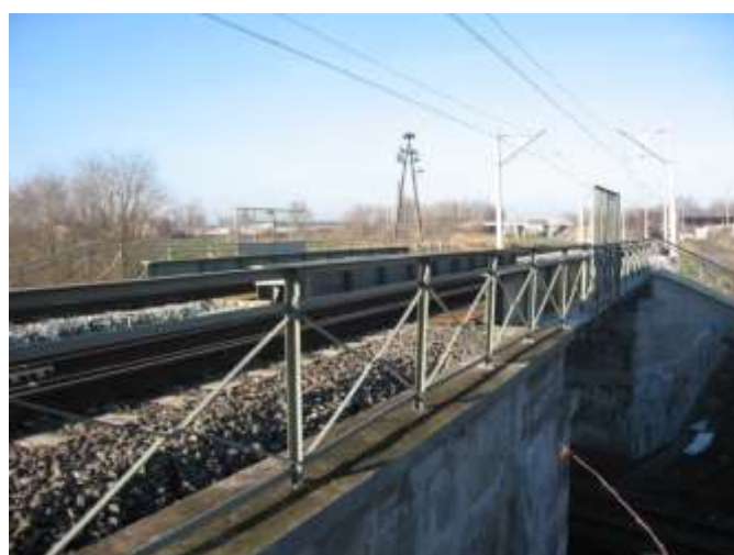
Zdjęcie 2. Most kolejowy, Opole ul. Głogowska - stan powłok 8 lat od aplikacji.
