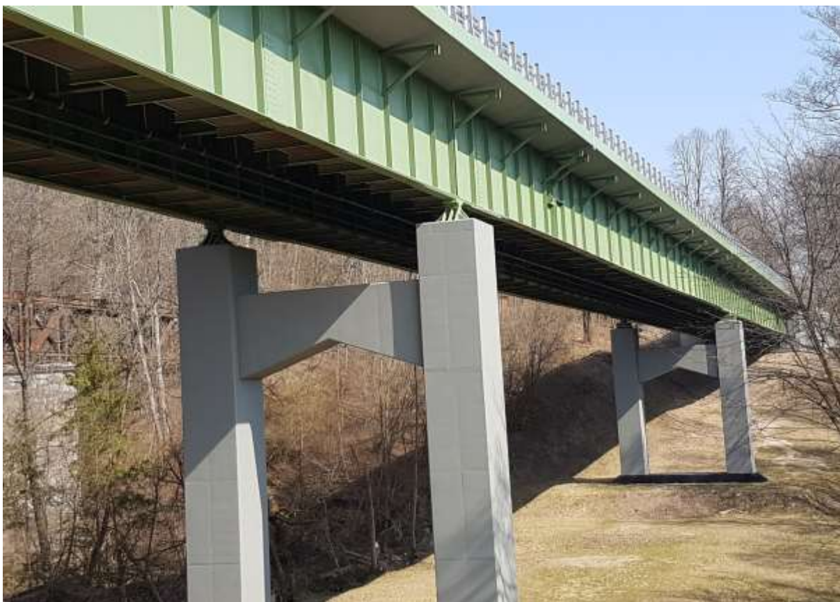
Zdjęcie 8. Konstrukcja mostu po wymalowaniu
