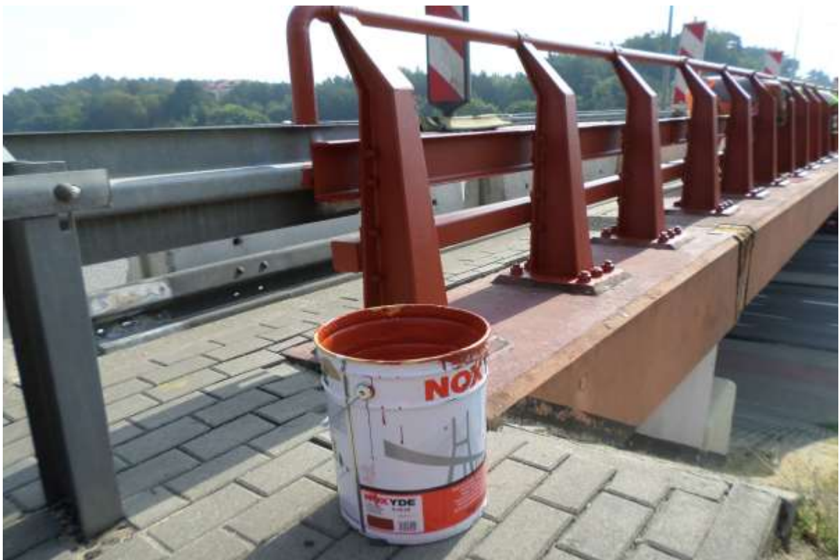
Zdjęcie 6. Nakładanie 1 warstwy Noxyde czerwony żelazowy
