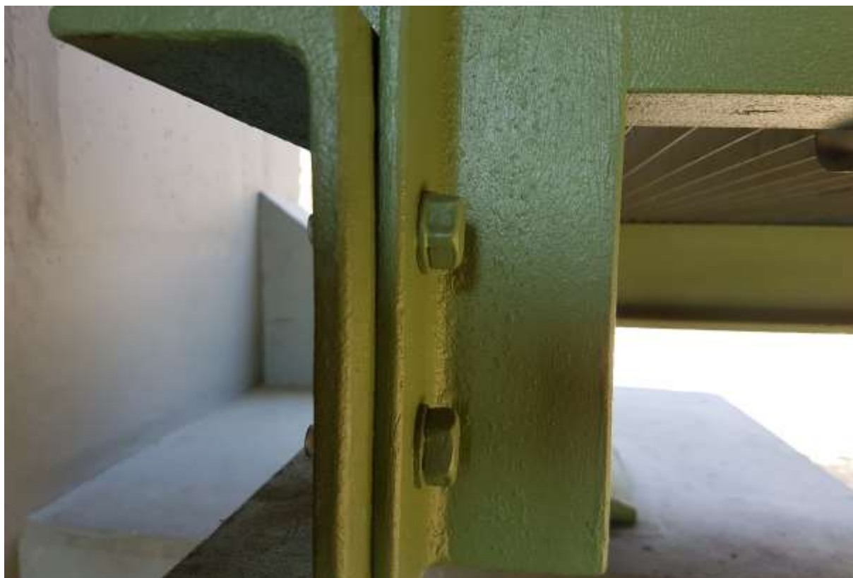
Zdjęcie 5. Konstrukcja mostu po wymalowaniu.
