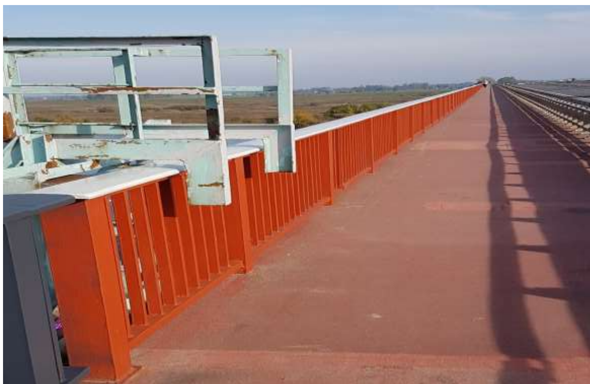
Zdjęcie 3. Malowanie konstrukcji pierwsza warstwa.
