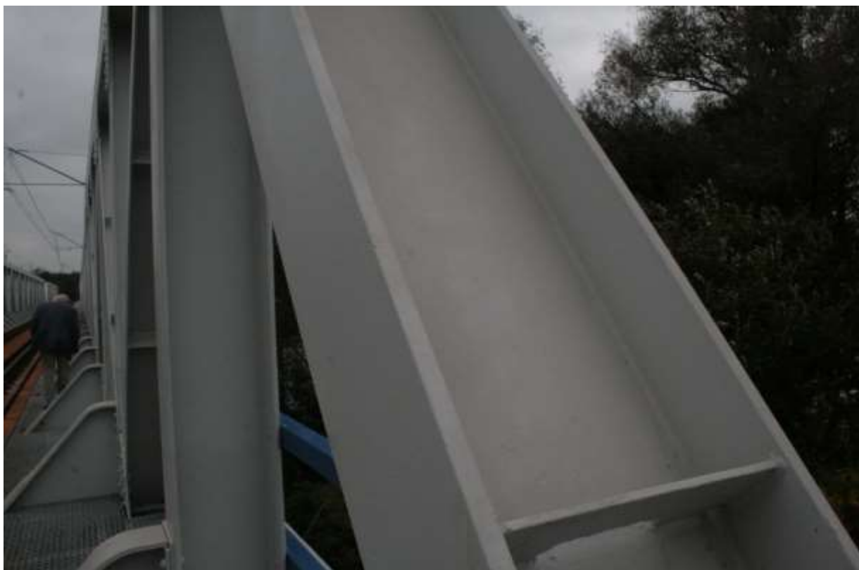
Zdjęcie 10. Konstrukcja po aplikacji farby Noxyde
