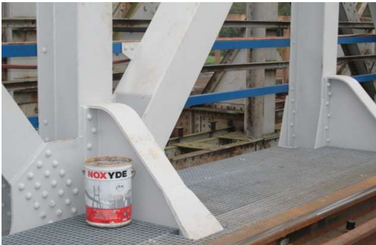
Zdjęcia 12. Konstrukcja po aplikacji farby Noxyde
