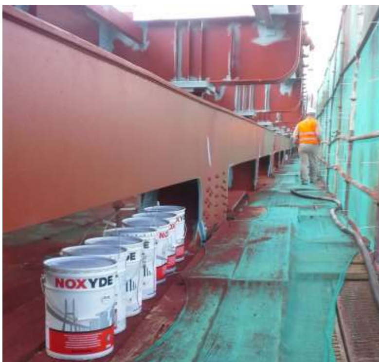
Zdjęcie. 4 konstrukcja w czasie aplikacji powłoki Noxyde
