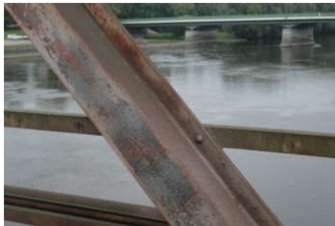
Zdjęcie 6. Stan konstrukcji po wyczyszczeniu
