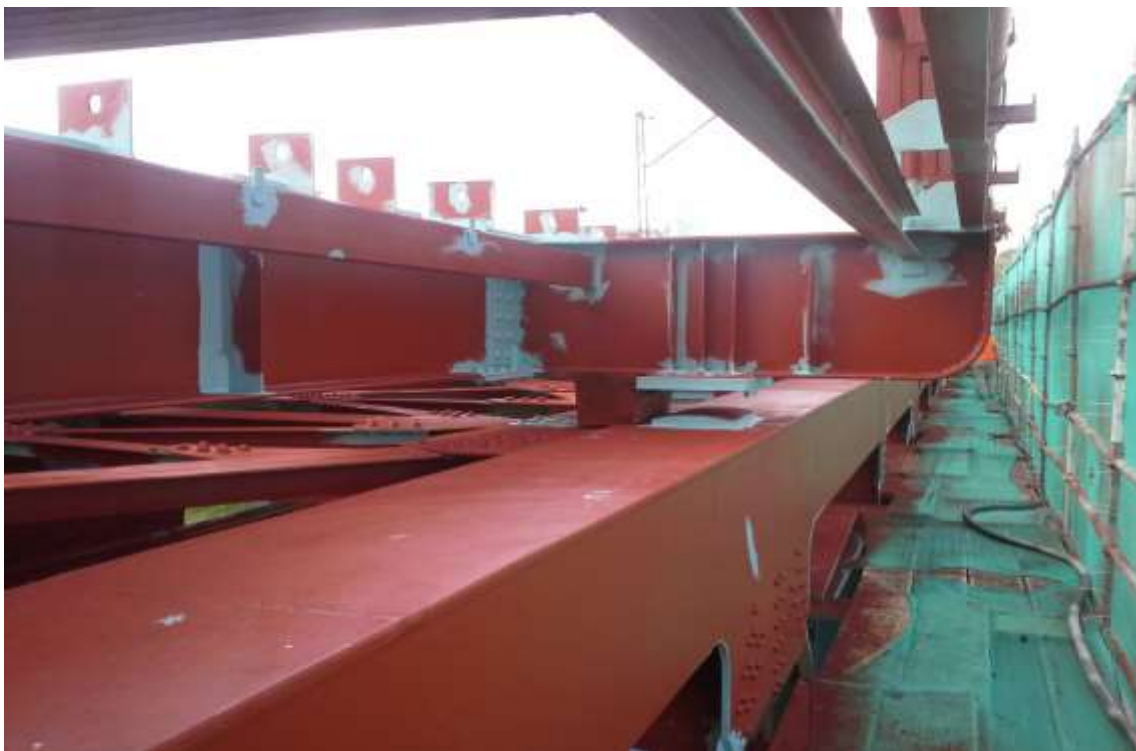
Zdjęcie. 3 konstrukcja po nałożeniu pierwszej warstwy
