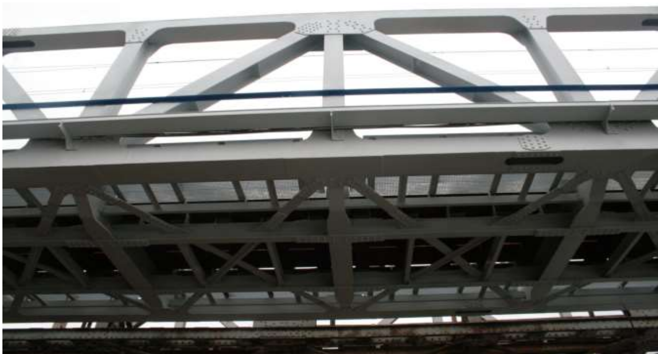
Zdjęcie 9. Konstrukcja po aplikacji farby Noxyde
