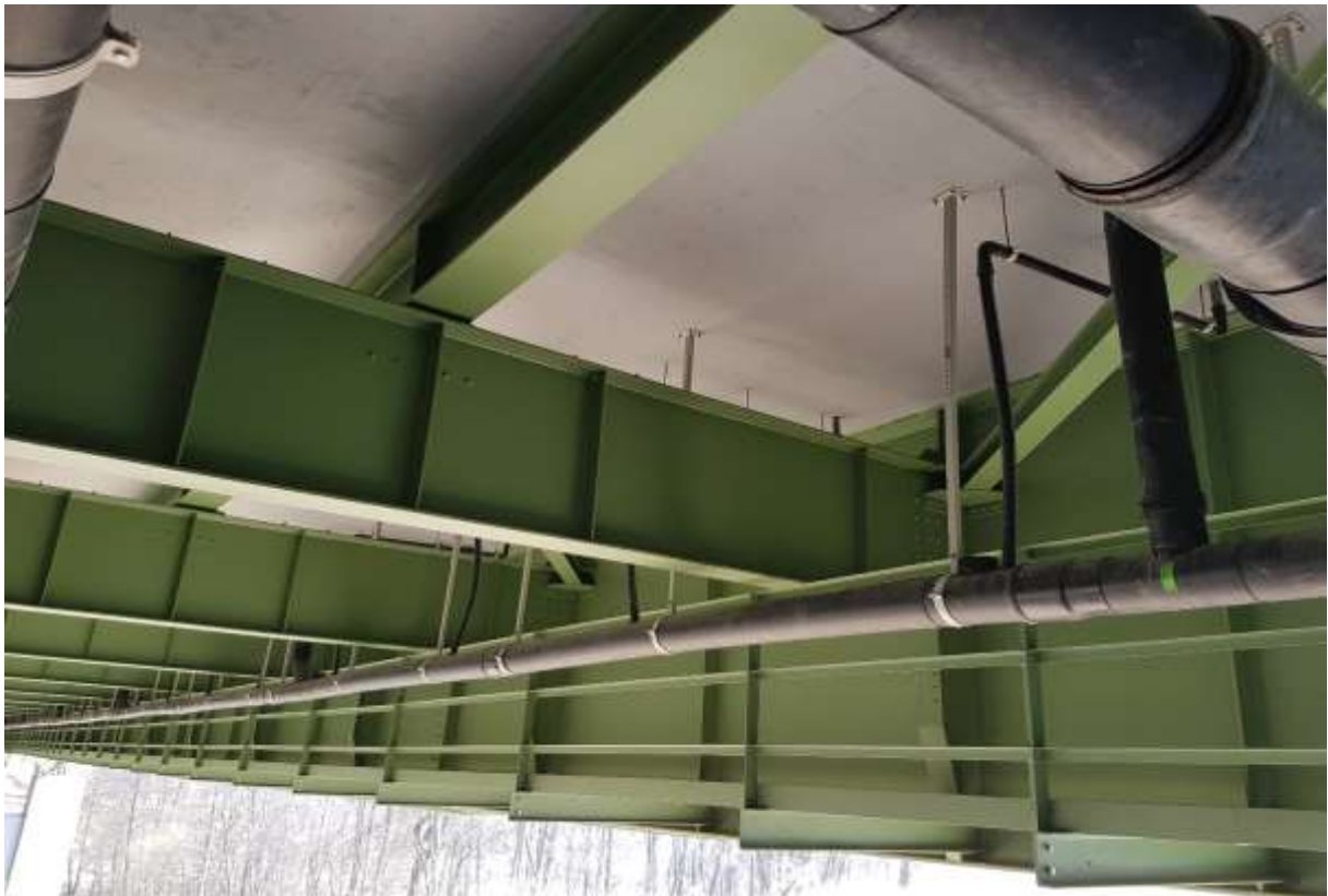
Zdjęcie 5. Konstrukcja mostu po wymalowaniu.
