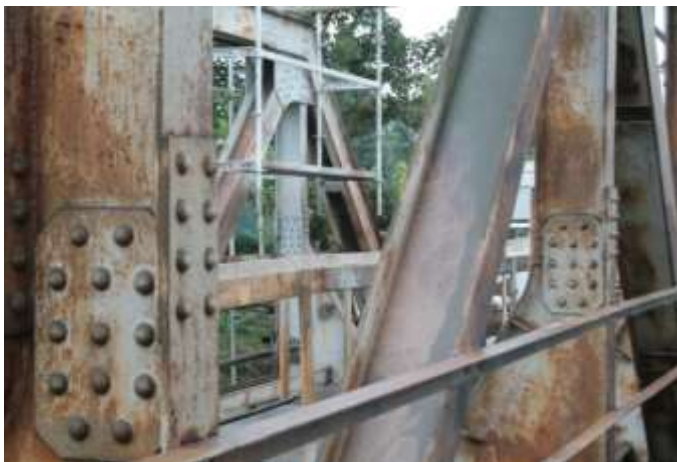
Zdjęcie 5. Stan konstrukcji po wyczyszczeniu
