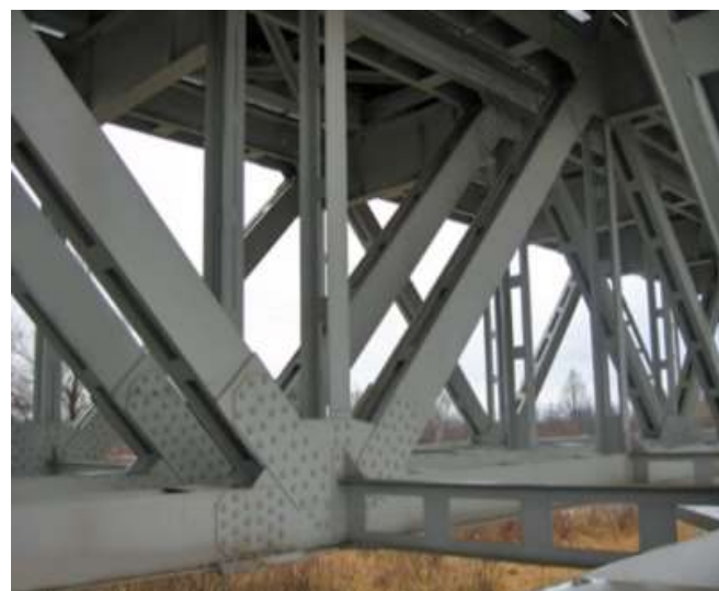
Zdjęcie 8. Stan konstrukcji 2 lata od wymalowania
