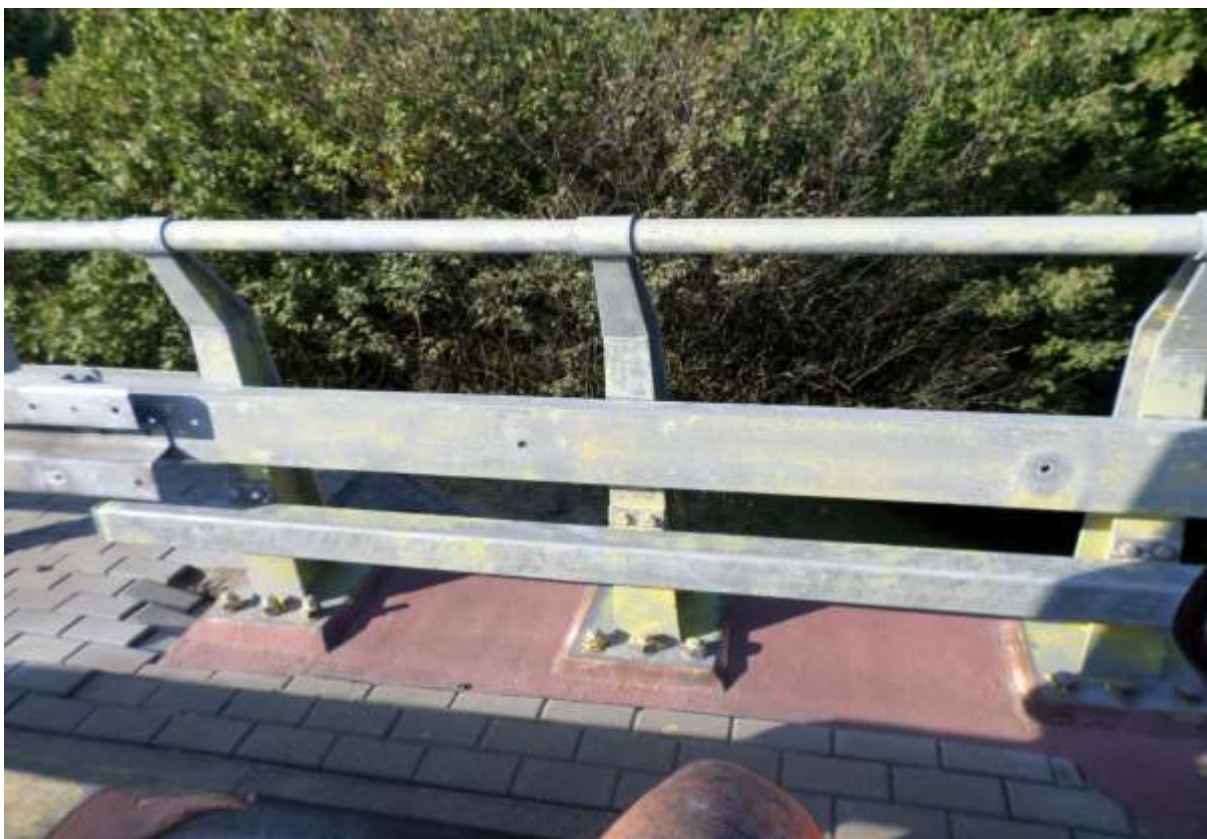
Zdjęcie 4. Konstrukcja przygotowana do malowania
