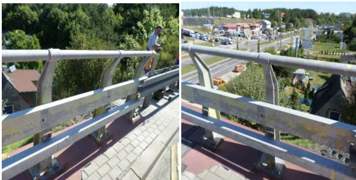
Zdjęcie 1.2. Przygotowanie powierzchni do malowania
