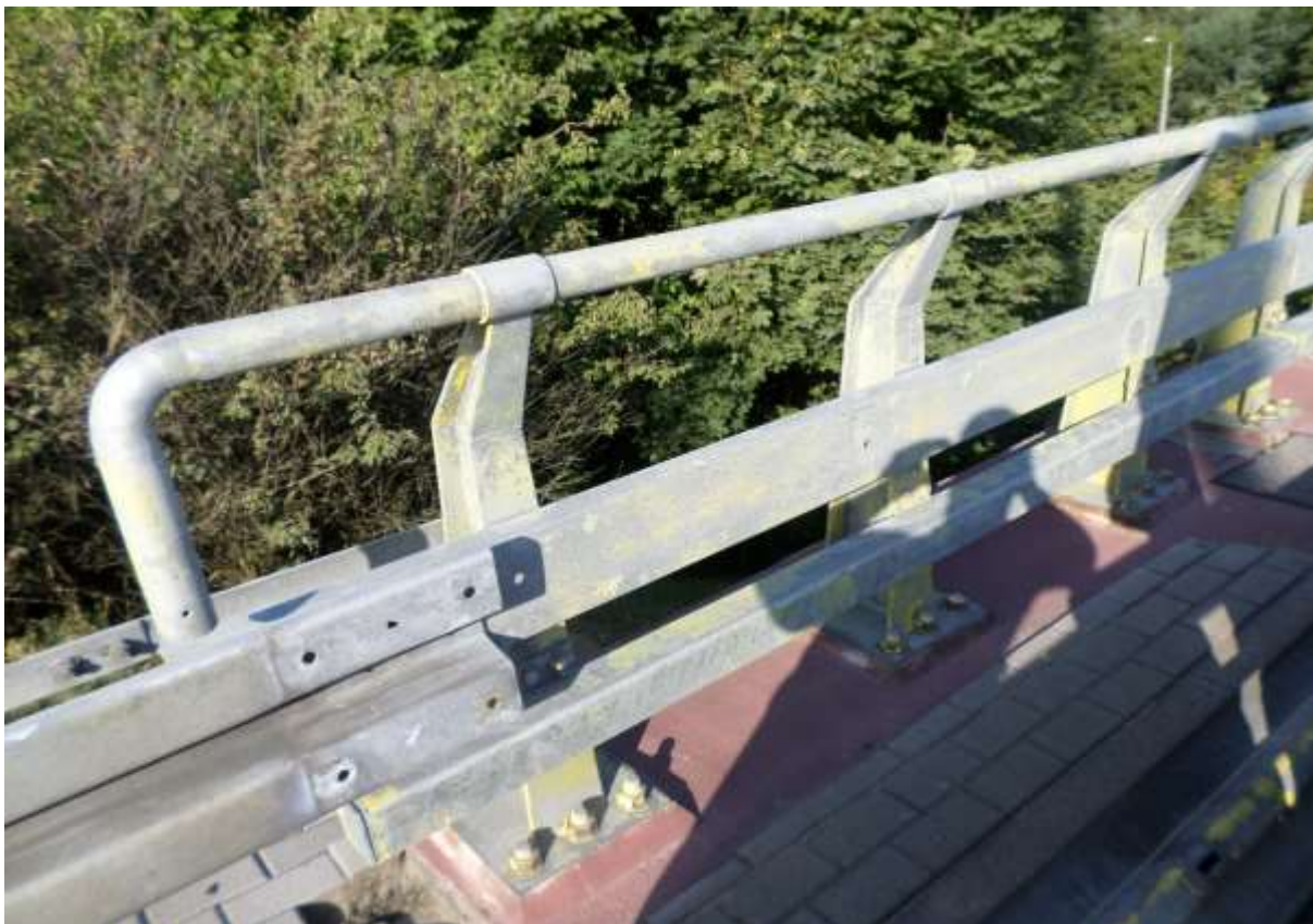
Zdjęcie 3. Konstrukcja przygotowana do malowania
