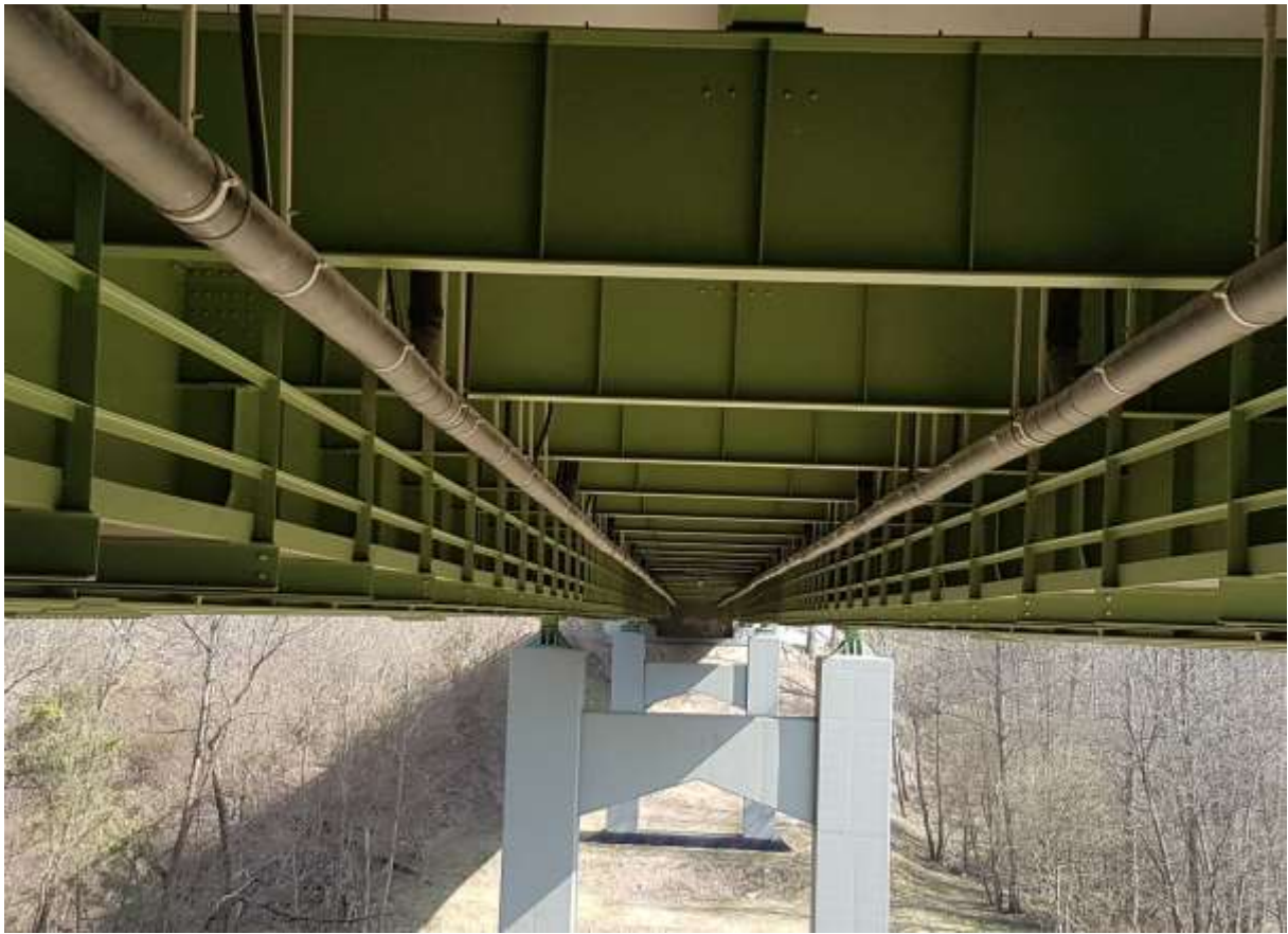
Zdjęcie 2. Konstrukcja mostu po wymalowaniu.
