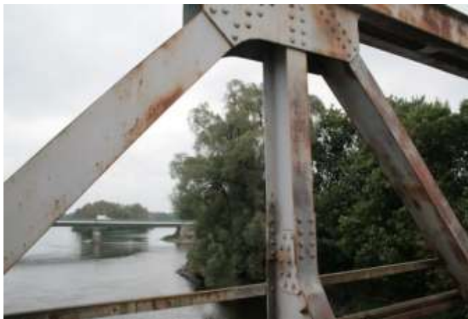
Zdjęcie 7. Stan konstrukcji po wyczyszczeniu
